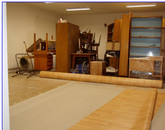
Foto č. 2 - Pokládka nového linolea v roce 2008
