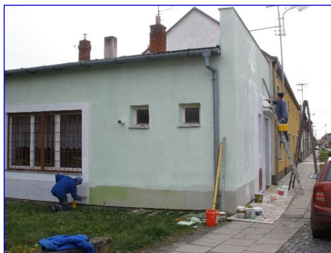
Foto č. 13 - Malířské práce na fasádě v roce 2013
