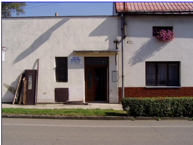
Foto č. 3 - Výměna vchodových dveří v roce 2008
